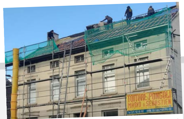
Travaux de toiture et isolation poste de Jumet
