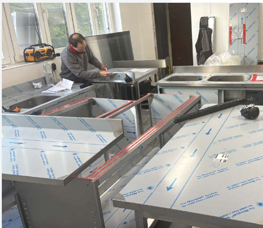
Montage des appareils de la cuisine du home Clair Matin
