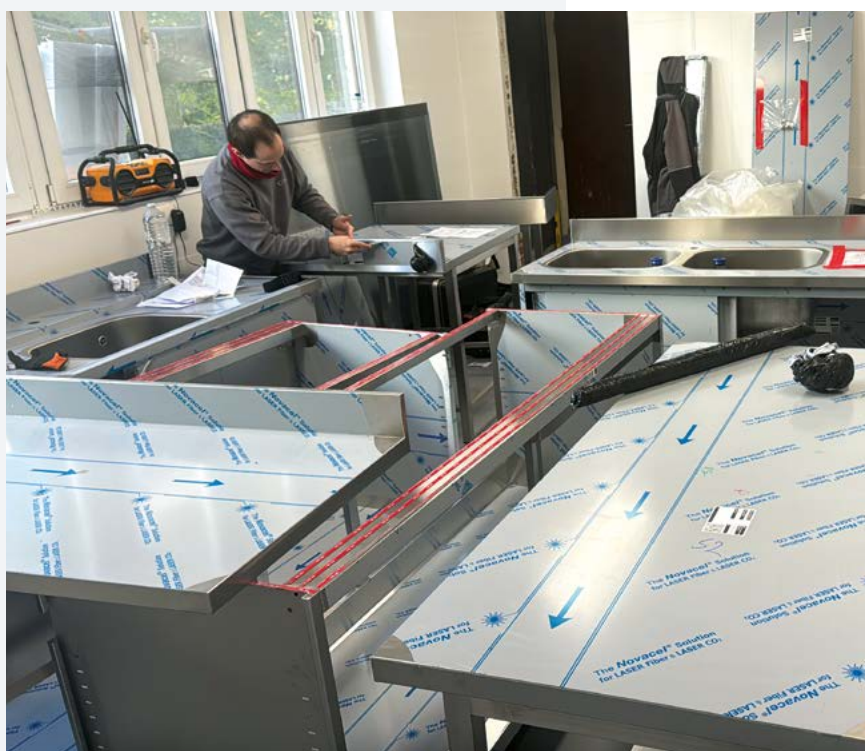
De keukenapparatuur wordt geïnstalleerd ten huize Clair Matin
